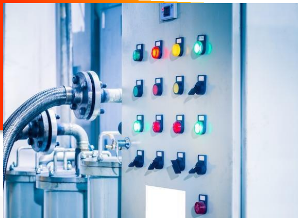
Équipements électricité industrielle
